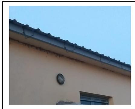
Figura 6. Abrazadera para la colocación de las canaletas.
